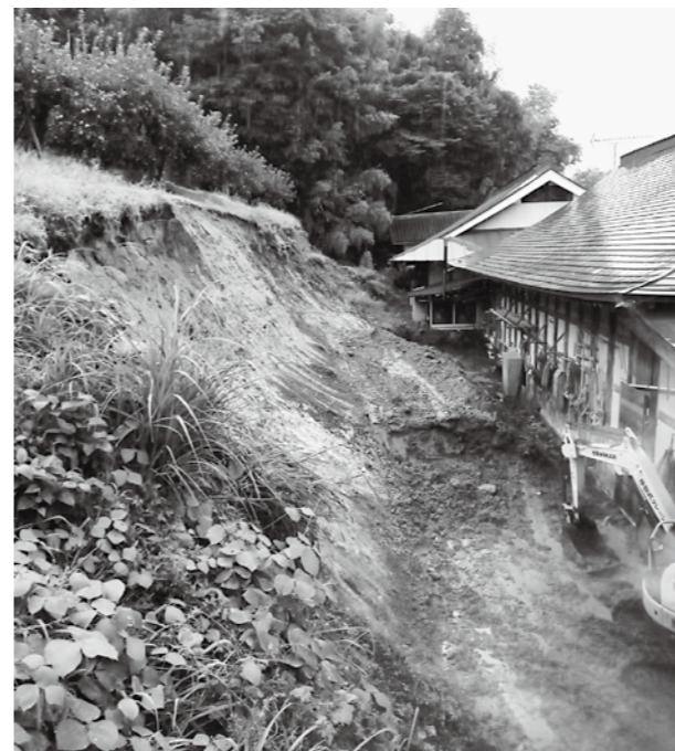
8月豪雨での土砂崩れ
