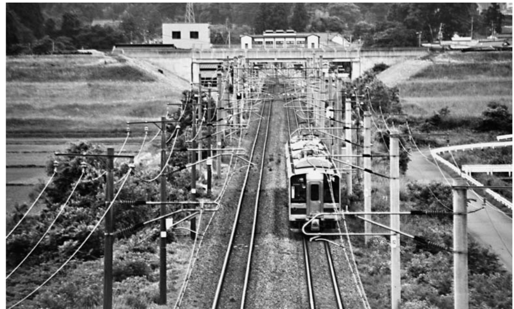
太田川堤防の下を東北本線が横断
