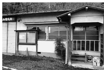
老朽化した第5分団の屯所
