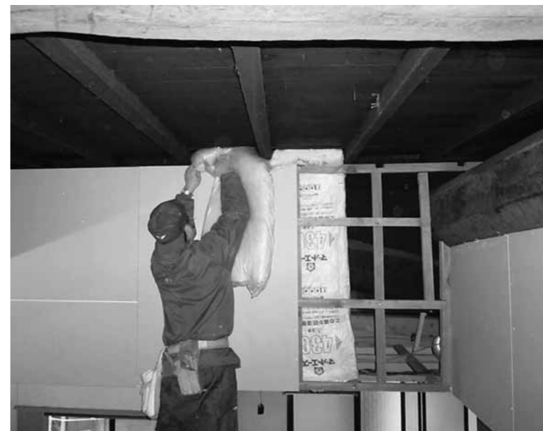
内装のリフォーム作業中
