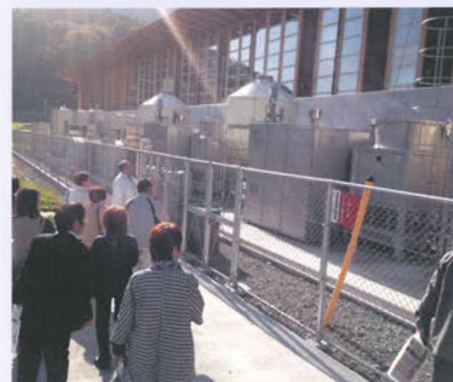
住田町役場新庁舎とペレット暖房機
